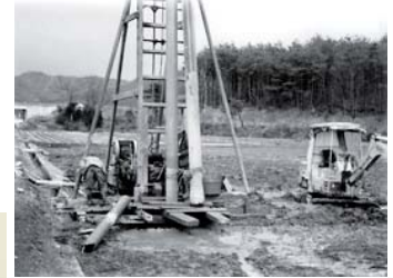
1982年(昭和57年) 特別養護老人ホーム青浄苑 建設予定地の造成に着手
